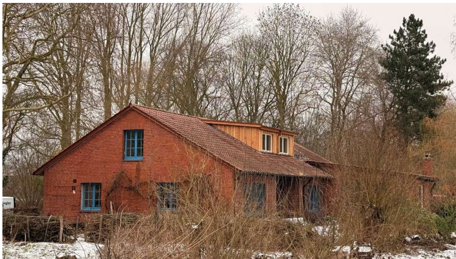
Neue Gauben für das Altenteilerhaus
